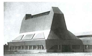
Hutfabrik Luckenwalde von Erich Mendelsohn, 1921-23. – Bild aus: Bruno Zevi (Hrsg.), Erich Mendelsohn, Basel 1999.
