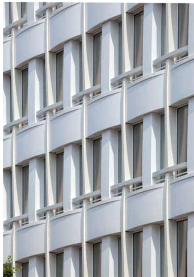
Agfa-Haus, «gewobene» Fassade aus Betonfertigteilen mit Zuschlagstoffen, gesäuert und hydrophobiert
