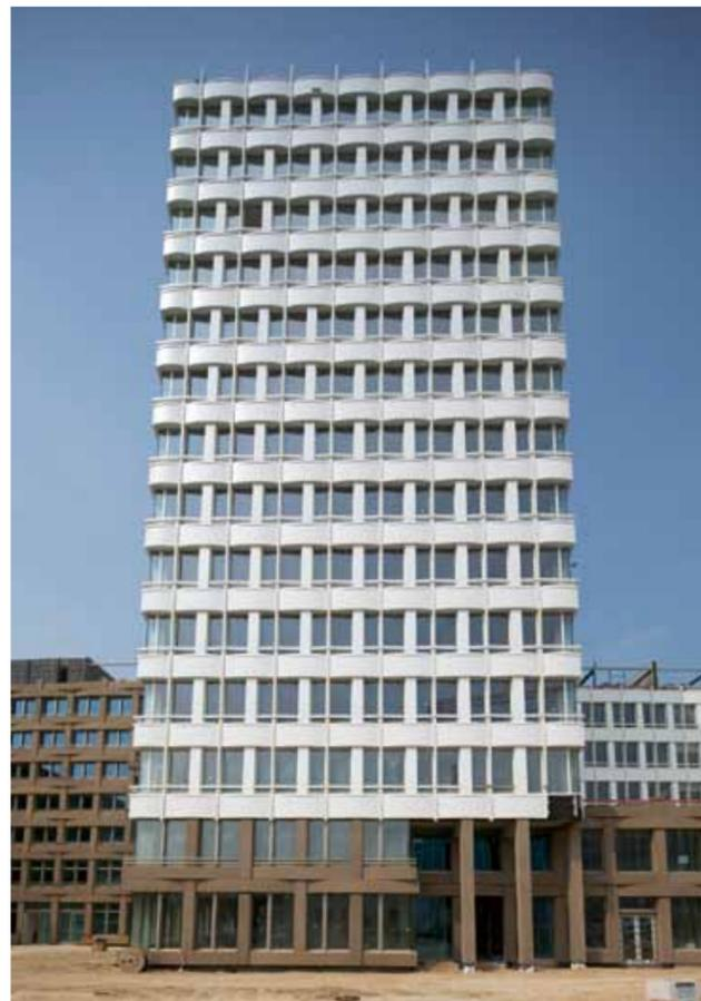
Agfa-Hochhaus, Metallfassade aus pulverbeschichtetem Aluminiumblech
