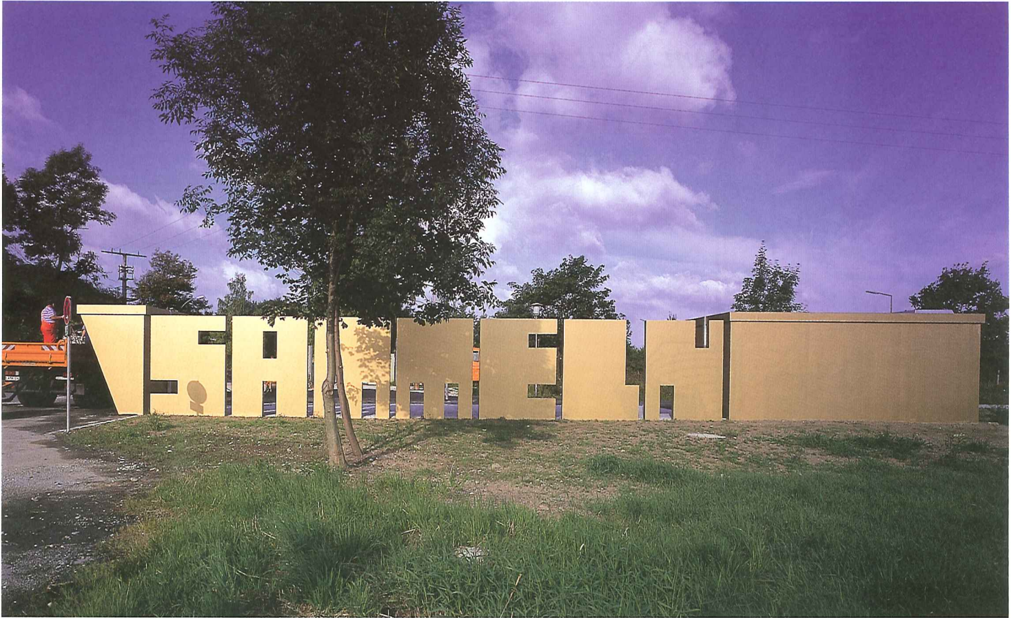
La peinture dorée sur les pièces en béton préfabriquées souligne la valeur des déchets recyclés
