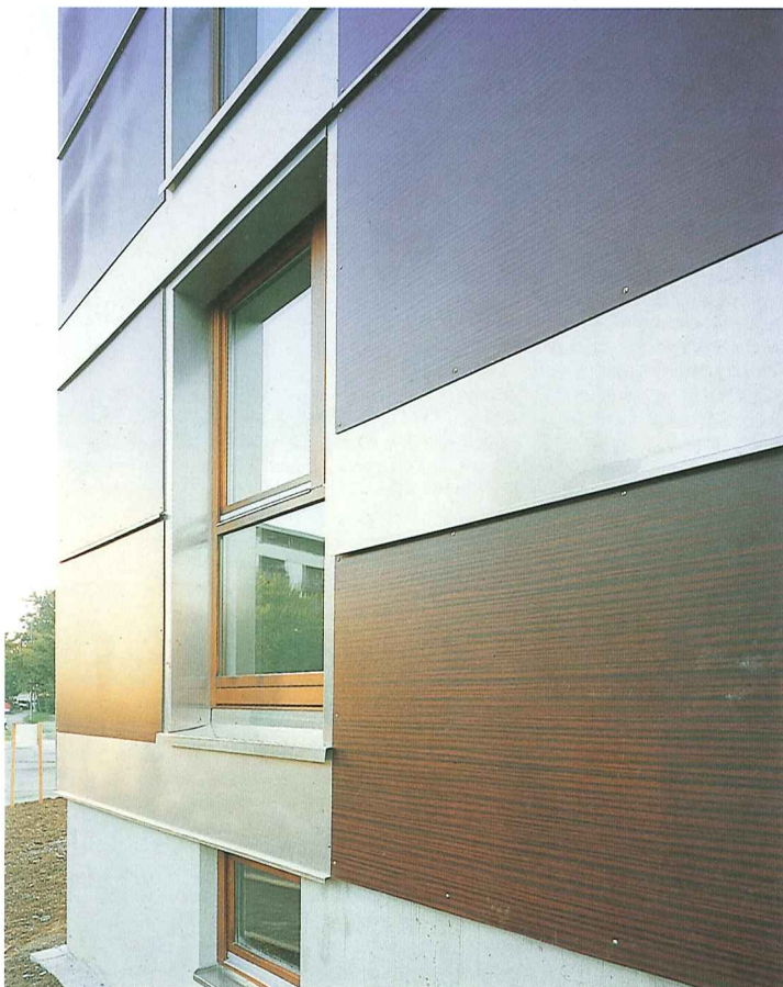
Détail de façade
