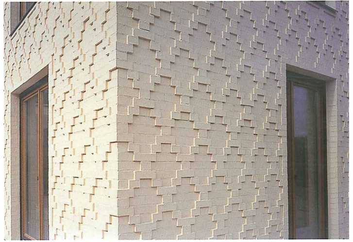
Application de la trame du revêtement en brique à un angle du bâtiment
