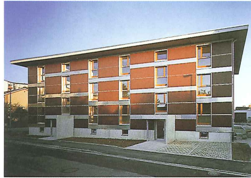
La façade sur rue animée par le contraste entre les bandeaux d'aluminium et le revêtement en imitation d'acajou
