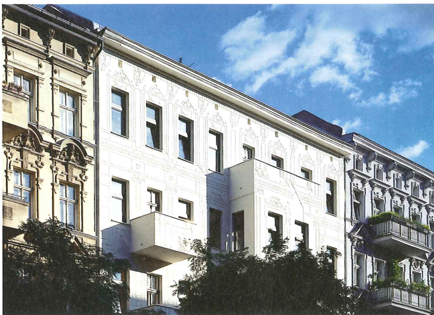
1, 2 Irritation: Das Bild der alten Fassade ist negativ in den Putz der renovierten geprägt. Das mit elektronischer Hilfe verfremdete Erscheinungsbild des Hauses weckt die Neugier der Passanten
