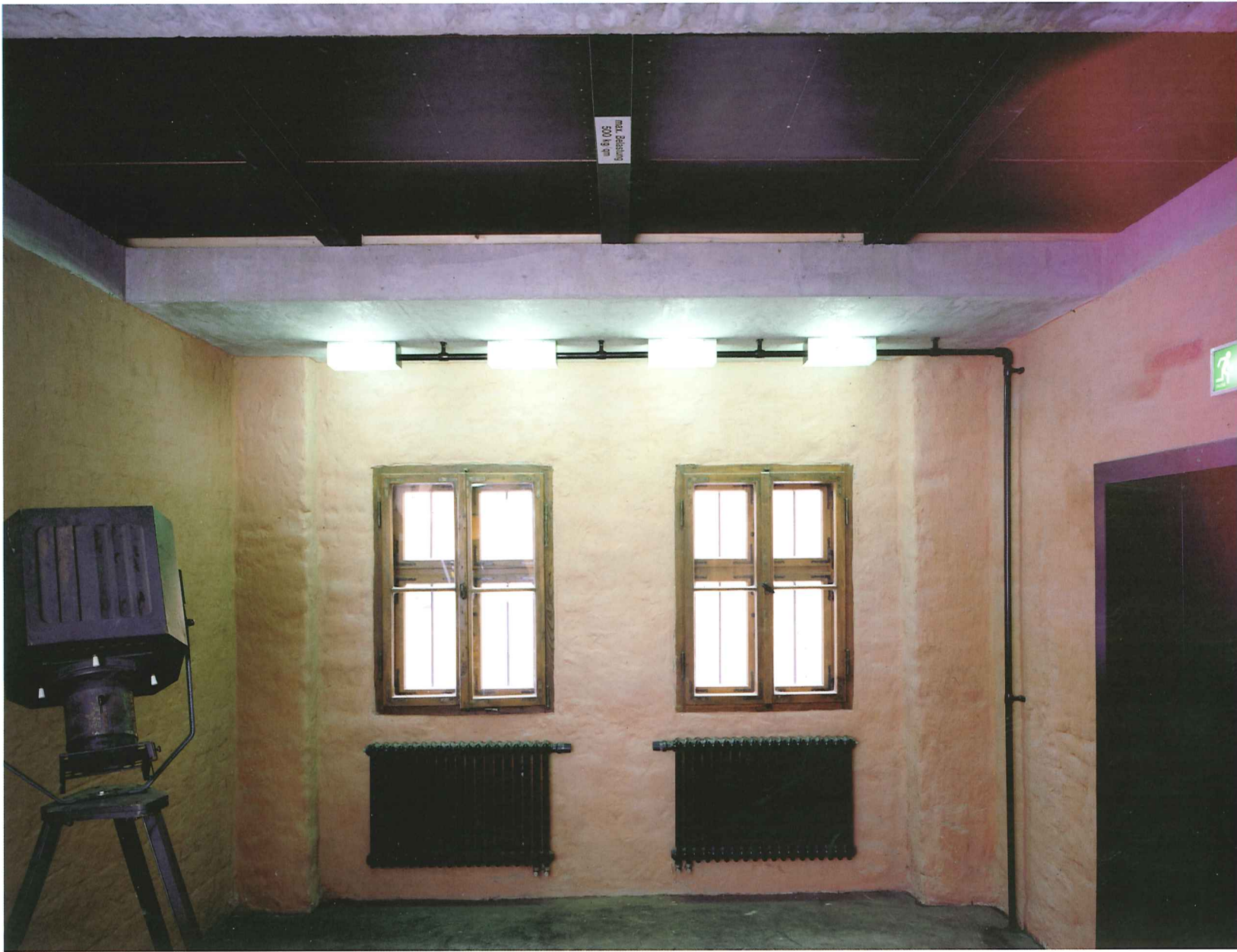
Interior y exterior de la zona de almacén Interior and exterior of the storage area
