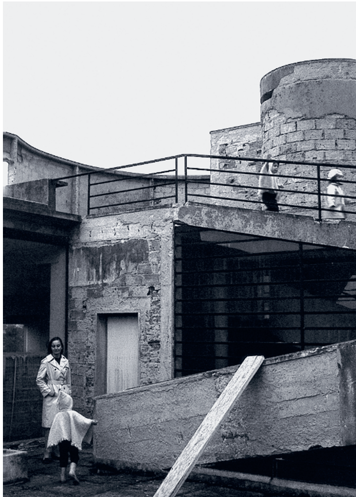
Le Corbusier, Villa Savoye, Paris 1931, nach der Fertigstellung Le Corbusier, Villa Savoye, Paris, vor der Sanierung 1964
