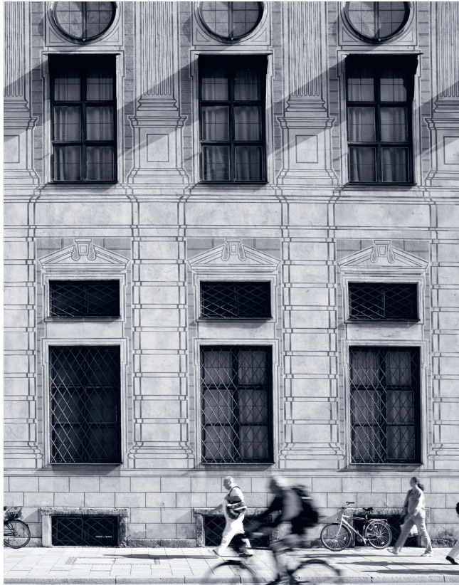
Putz als Surrogatmaterial, Rekonstruktion Fassade der Alten Residenz, München; Fassadengliederung 17. Jh., Wiederaufbau 20. Jh.
