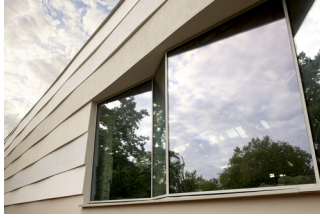
Hild und K: Revitalisierung «Bikini» Berlin, 2013. Die verputzte Aussenwärmedämmung der Nordfassade ist in horizontalen, bewegten Bändern reliefiert. Ihr Putz enthält die geschredderten Glaselemente der alten Fassade und glitzert in der Sonne.
