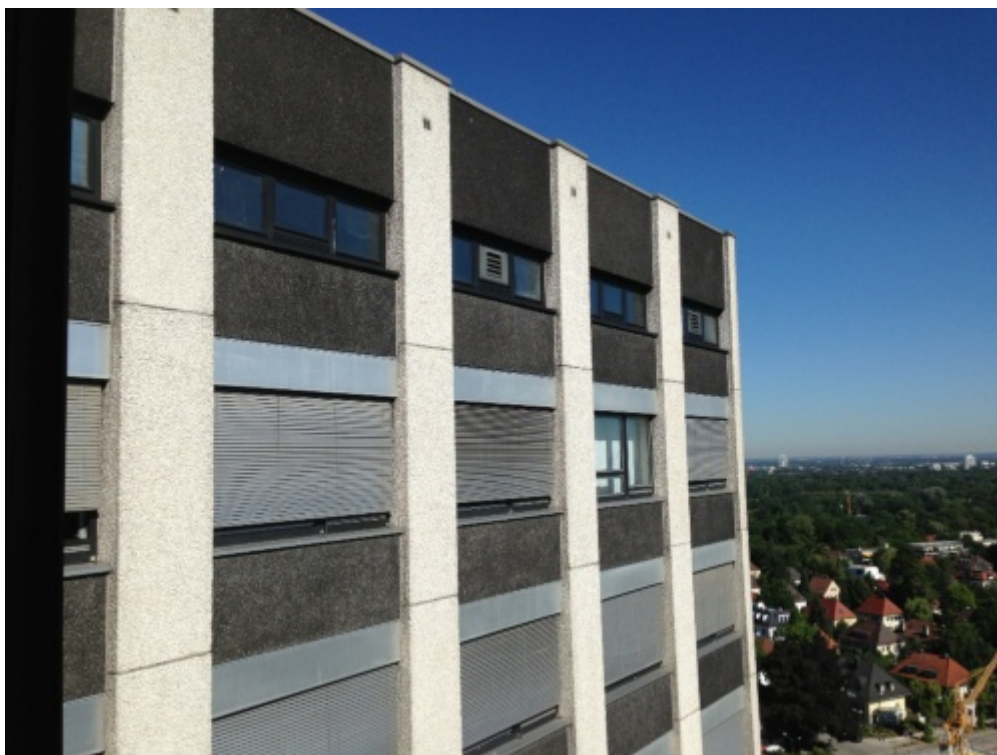
改修前のファサード（撮影：Hild und K Architekten） [画像のクリックで拡大表示]
