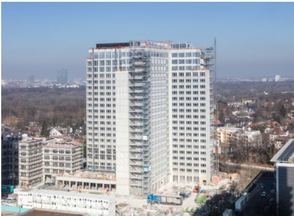
改修中の様子（撮影：Michael Heinrich）
