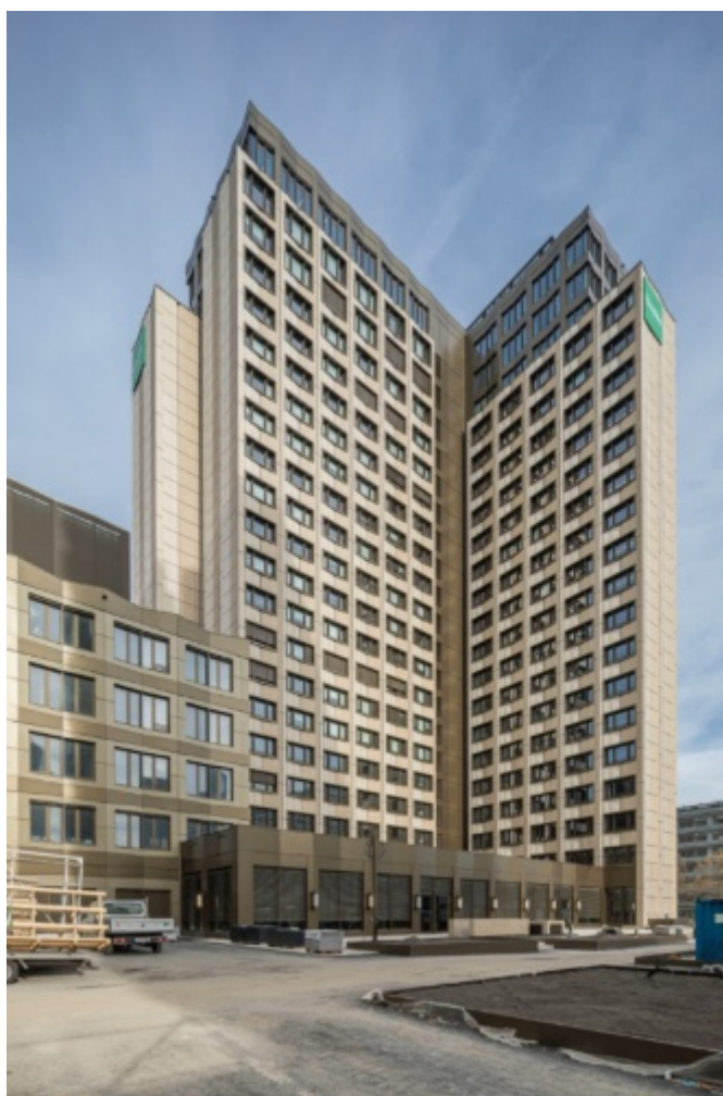
改修後のバイヴァオフィスビル (撮影 : Michael Heinrich) [画像のクリックで拡大表示]
