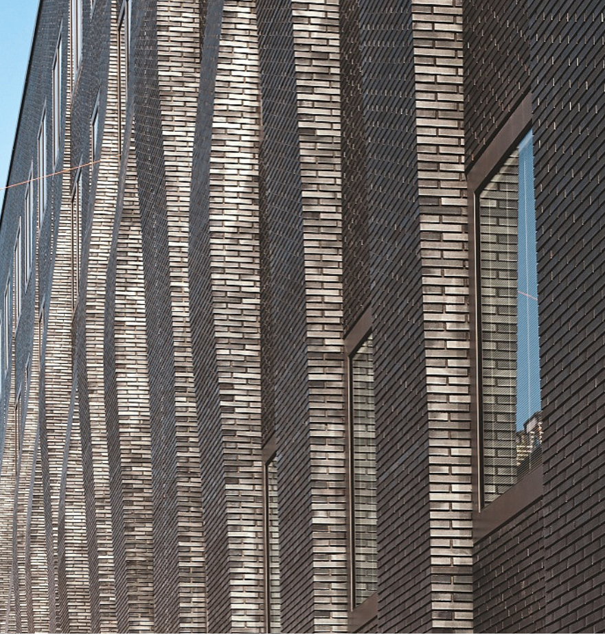
Fassadenausschnitt mit den versetzten Wellenbewegungen der Pfeiler | Façade detail with the offset wave movements of the pillars
