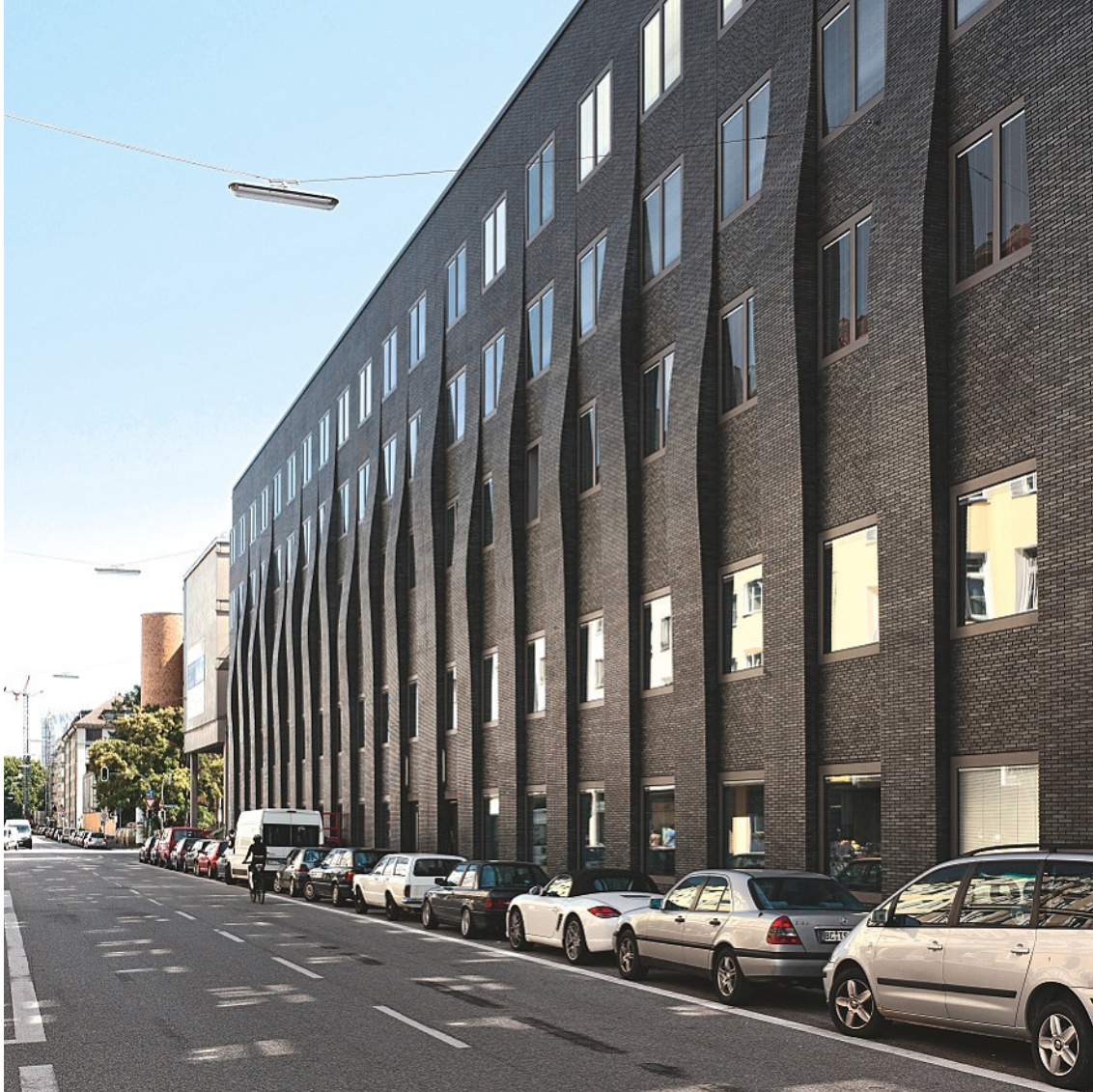
Die sanierte Fassade entlang der Luisenstraße | The renovated façade along Luisenstraße
