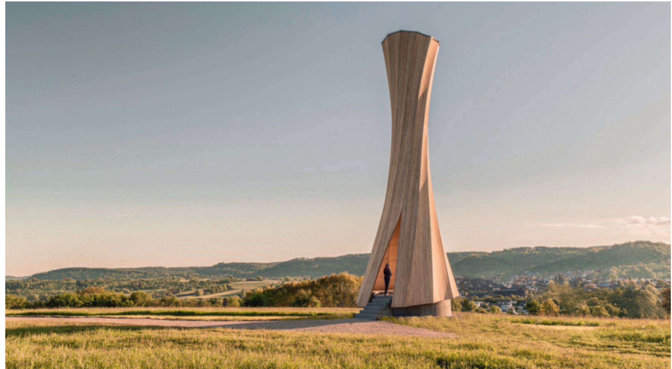
Für den Turm wurden Holzelemente verwendet, die sich bei der Trocknung in die gewünschte Form krümmen. Die Grafiken oben zeigen den Verformungsgrad, die Verwendung des Brettsperrholzes und die Verbindungsstücke. Bilder: ©ICD/ITKE University of Stuttgart
