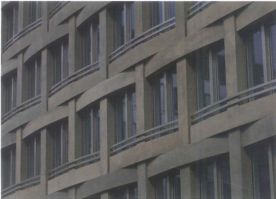
Fassadendetail mit den Beton-Fertigteilen und den ebenfalls geschwungenen Brüstungsstäben. Sand und Pigmente bestimmen die Farbe.
