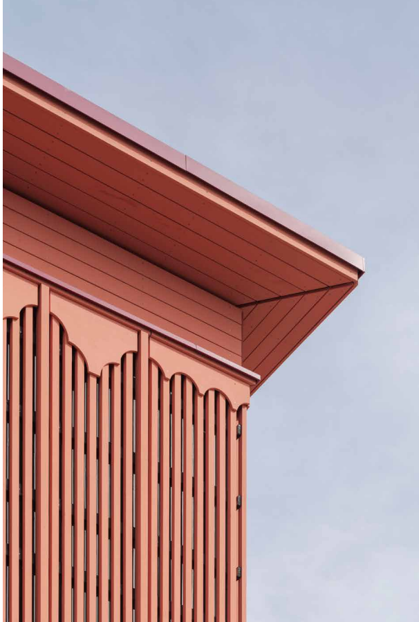
Die »Bordüre« hat die Opferbretter im autochthonen Holzbau zum Vorbild, dient aber auch dem Wetterschutz. The 'border' is modelled on the so-called sacrificial boards (protective wooden panelling) used in traditional timber construction. It also serves to protect against the weather.
