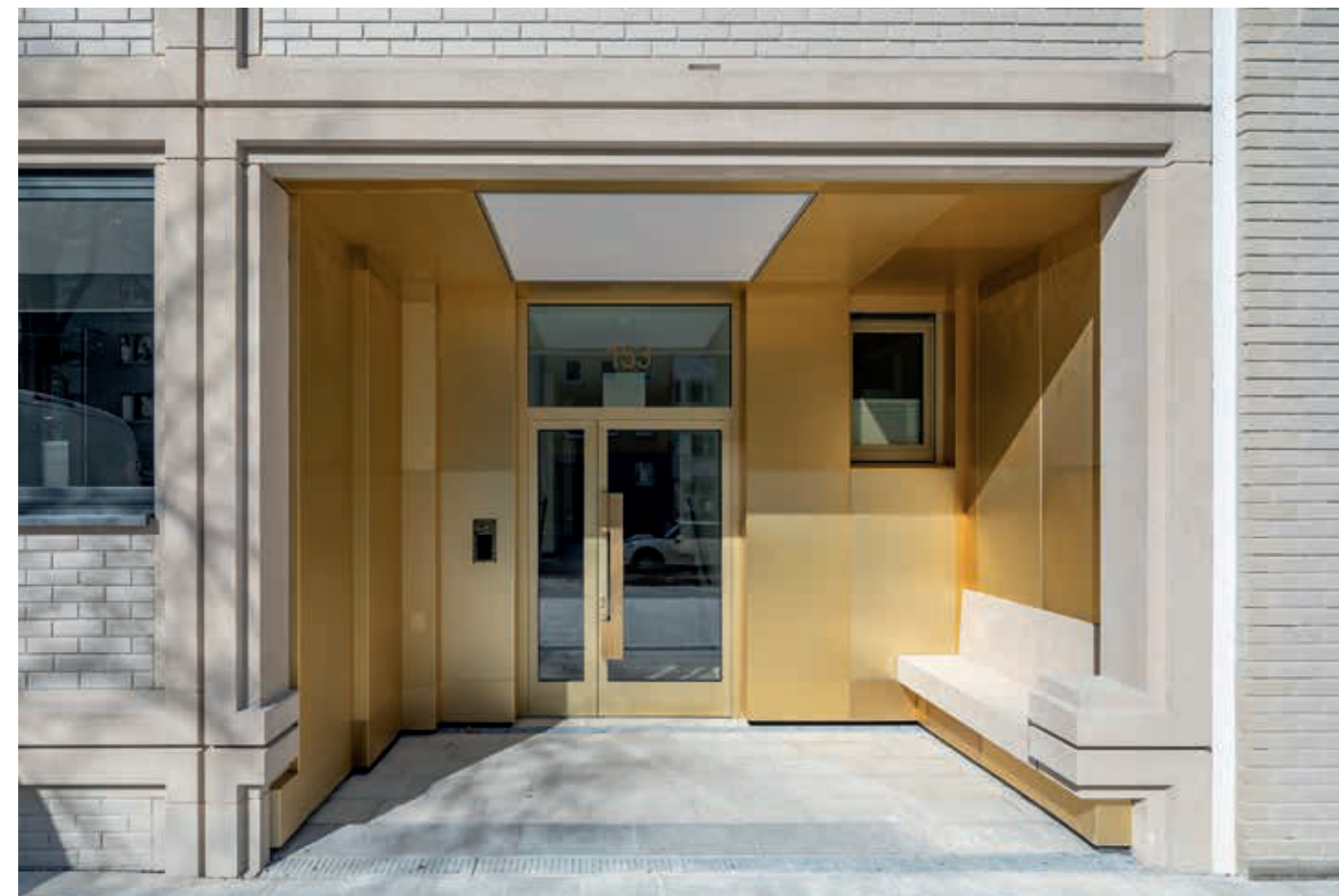
Die zurückgesetzten Hauseingänge rhythmisieren den verlinkerten Sockelbereich. The recessed entrances lend a sense of rhythm to the clinker-brick plinth.
