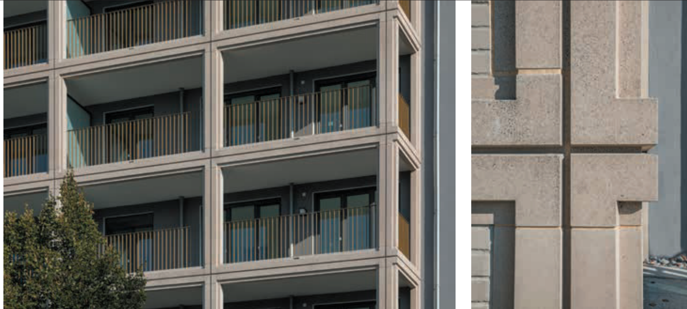
Die vorgestellten Balkone bilden entlang der Straßenfronten eine großformatige Struktur. The prefabricated balconies form a large-scale structure along the street.
