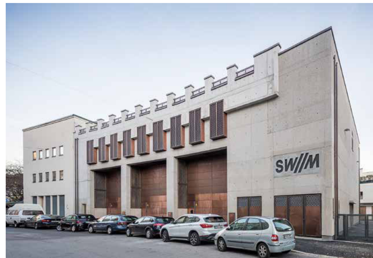
Drei große Einbringöffnungen für Transformatoren bestimmen die Gliederung der Hauptfassade. Three large recessed openings in front of the transformers define the composition of the main façade.
