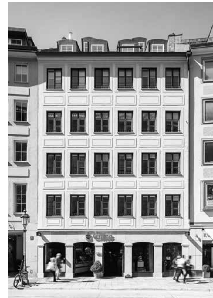
Umbau und Sanierung Wohnhaus Residenzstraße, 2015
