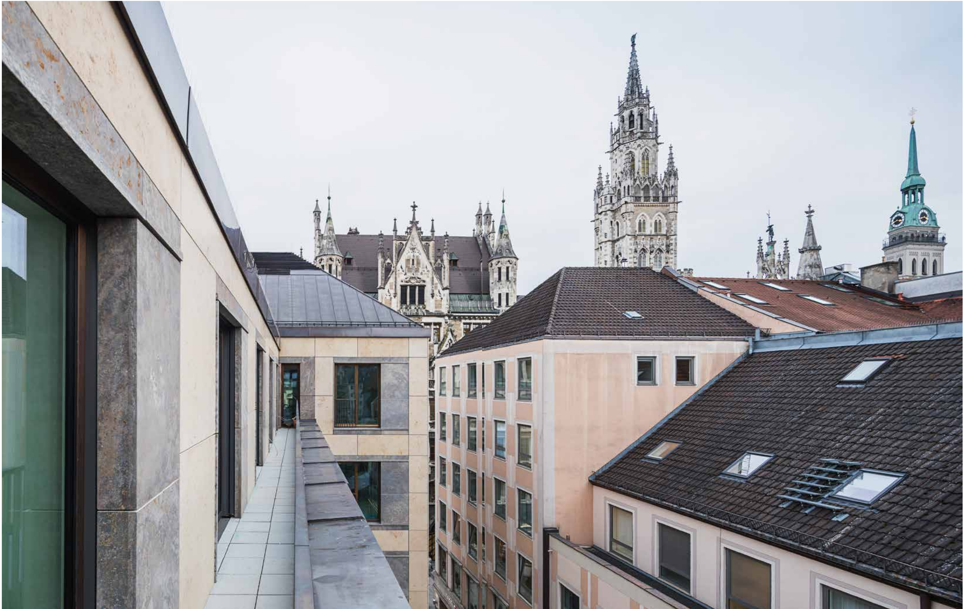
Prominente Lage gegenüber dem Rathaus: Wie bei der Vorgängerfassade aus den 1950ern mischen sich auch heute Jura- und Muschelkalksteinplatten.
