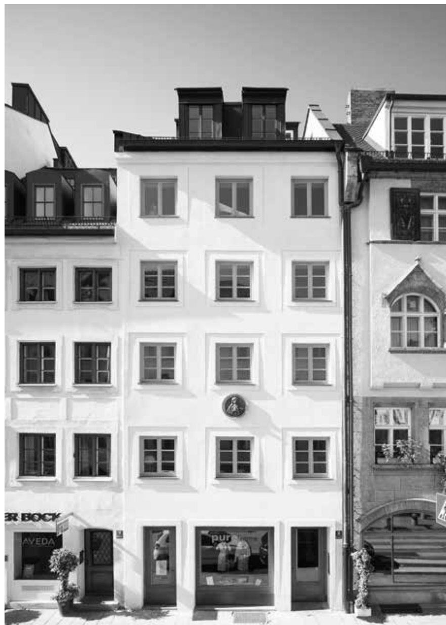
Umbau und Sanierung Wohnhaus Brunnenstraße, 2009
